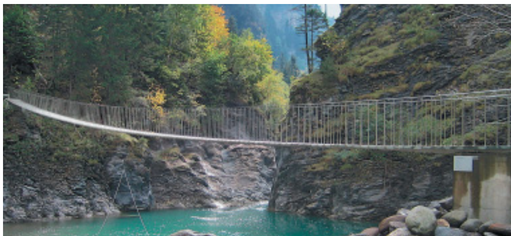
Quattro sottili nastri tesi di acciaio inossidabile e una passerella pedonale di lastre in pietra naturale continuano il sentiero attraverso la gola larga 40 m.
