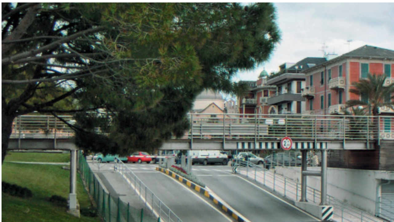
Il ponte pedonale di acciaio inossidabile supera la strada di accesso al porto turistico.
