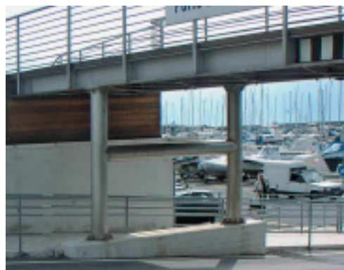
I tralicci con sezione ad H sostengono la struttura e accorciano la luce del ponte.
