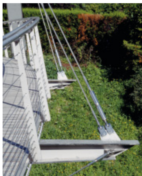
Coppie di tiranti congiungono le traverse all'arco.
