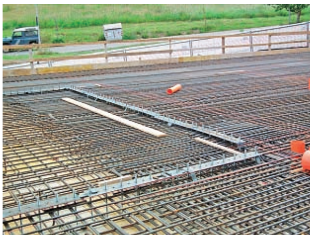
Figura 1.25 Esempio di tirafondo e dima
