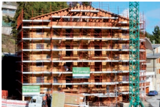
Figura 1.4 Alexander Residence in una fase della realizzazione
