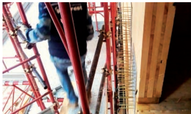
Figura 1.14 Esempio di utilizzo vite per connessione pannello-piastra
