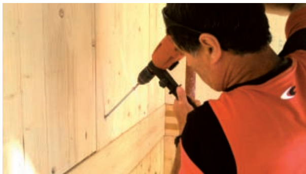
Figura 1.15 Esempio di utilizzo vite per connessione pannello-solaio
