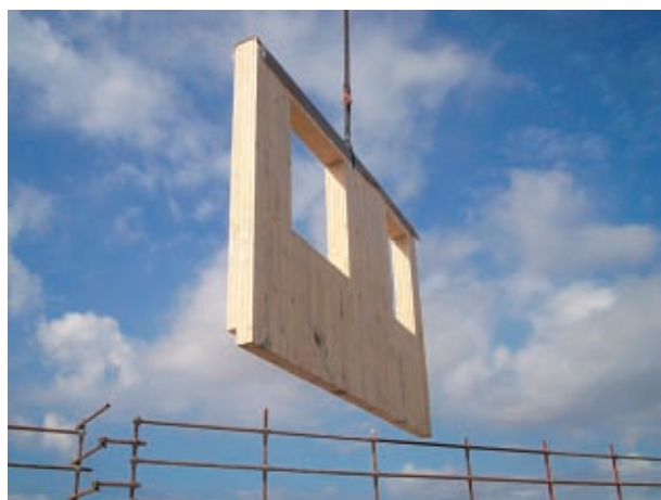
Figura 1.2 Sollevamento di una parete prefabbricata in legno
