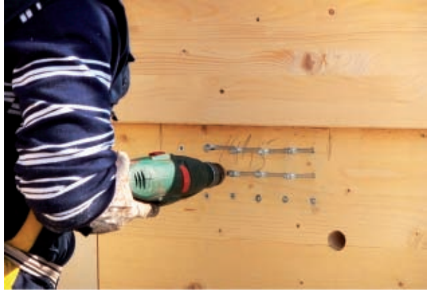
Figura 1.20 Posa in opera di perni autoforanti
