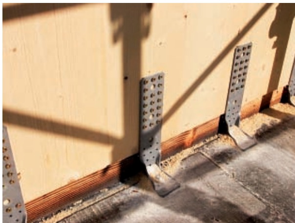
Figura 1.24 Angolare WKR fissaggio meccanico 5 (fonte: Rothoblaas)
