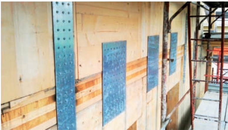
Figura 1.23. Piastre rettangolari per collegamento pareti
