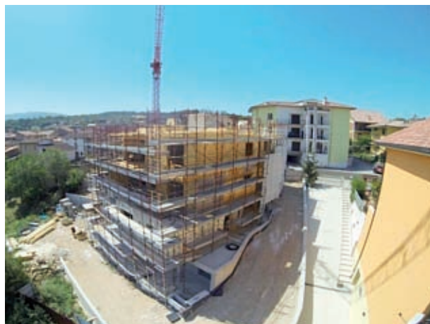
Figura 1.6 Edificio a struttura XLAM in costruzione
